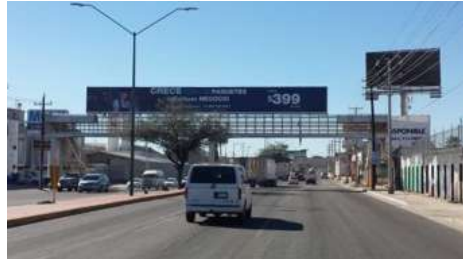
Vista CALLE SAN JAVIER - CALLE DEL COBRE ESTE-OESTE
